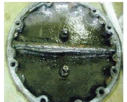
鏡板にも錆はない
