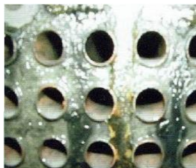
熱交換器銅管の地色が見える
