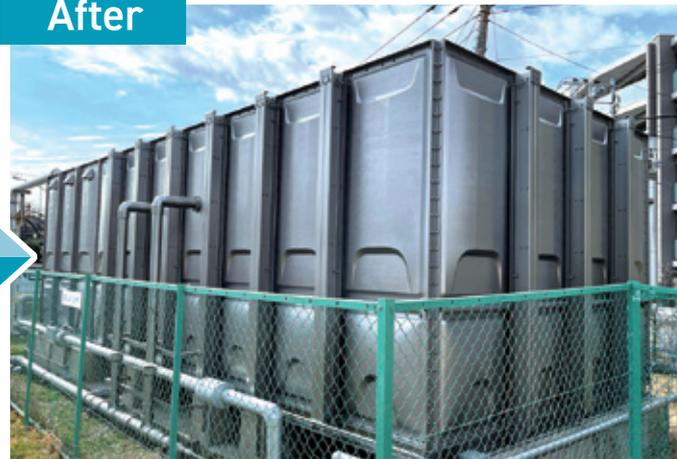
今まで止めることの出来なかったFRP(強化プラスチック)の加水分解を止めることが出来る特殊塗料となります。既存のFRP貯水槽にタンクステンコート塗料の塗膜施工をして頂くだけで全く新しい水槽に生まれ変わります。耐用年数を延長することにより産業廃棄物の発生を抑え、環境に優しい21世紀型の工法です。
