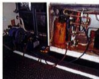
真空引き、冷媒再充填、試運転
